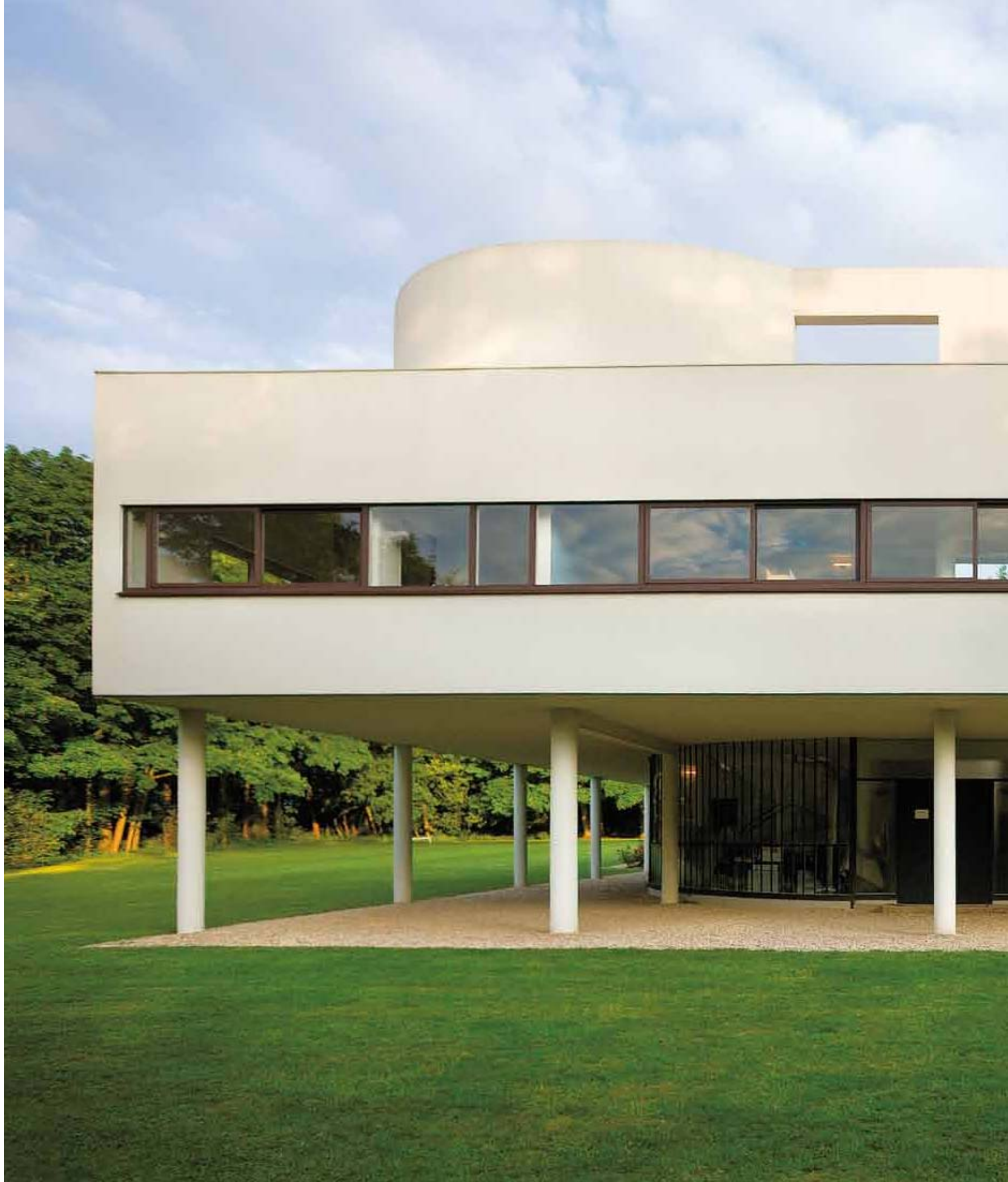
Villa Savoye Poissy, France 1929-1931 Architecte : Le Corbusier (F)
